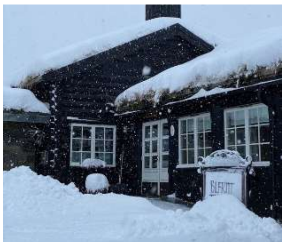
Det er allerede mye snø og full vinter på Danebu. Foto tatt 19. november.
