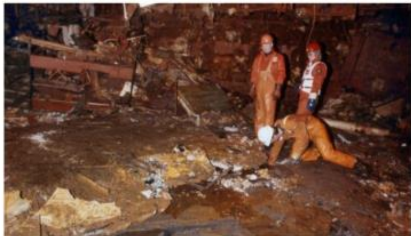
Frå arbeidet inni «Alexander L. Kielland»-plattformen i oktober 1982, tre og et halvt år etter havariet. Smulgen skjedde i Gandsfjorden.
