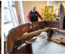
Opplysningsvesenets er nylig på etablering av det som var det horisontale staget mellom B- og K-stag på «Kielland»-plattformen. © J. L. Lian
