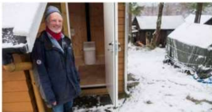
Frederik Hansen ser ikke behov for å installere vannklosett i hytta si fra 1936.
