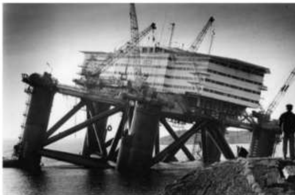
Veritas og Sjøfartdirektoratet på Stavanger Drilling I A/S en rekke endringer på tvillingplattformen «Henrik Ibsen». Blant annet å montere nevnte stag mellom B og C og C og D. Det ble også innført strengere krav til forankring og krav om ankerwirer med bruddstyrke på 350 tonn, mot tidligere 310. 7. april 1980 fikk «Henrik Ibsen» 20 prosent slagide mens den lå i Tananger. FOTO: EGG DRILLING
