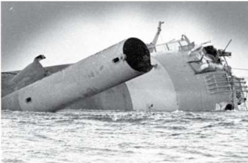
«På tidspunktet for ulykken hadde sprekken i D-leggen ved sveiseskjøten for hydrofonrøret fått lov å bevege seg rundt tre firedeler av staget. Det var da ikke behov for særlige krefter for å løse D-leggen. Teorien om at ulykken skyldtes særegne belastninger på grunn av systemfeil ved oppankringen (8 ankere og ikke 10) og håndteringen av ankerwirene (feil bruk), er hverken nødvendig eller riktig for å forklare ulykken», skriver Pål Miltsem. FOTO: JOMAS HAARVRETTAD
