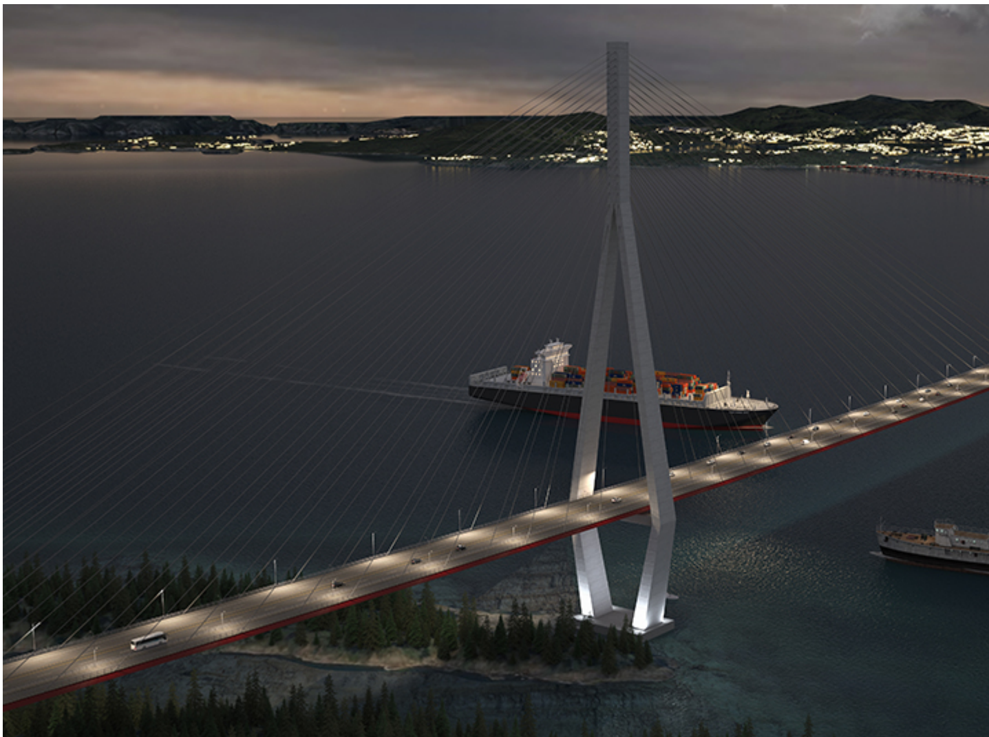
Bjørnafjord-broen, iflg. Statens Vegvesen.
