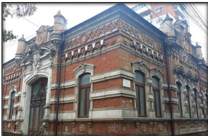
Fig.1. Casa Balș- fațada sud-estică (sursă foto: arhiva personală, octombrie 2018)
