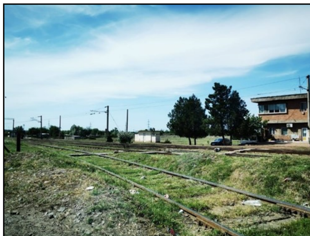
Foto 3. Calea ferată de acces la Șantierul naval Damen Sursa: Mocanu, 2020
