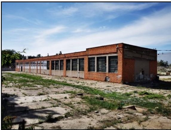
Foto 1. Fostă hală industrială
