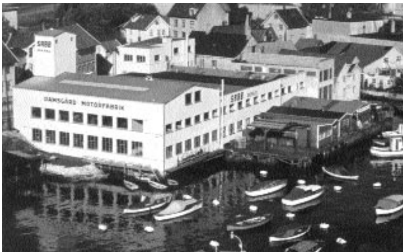
En moderne bedrift har tatt form. Damsgårdsveien 113, 4. byggetrinn.. Året er 1963.
